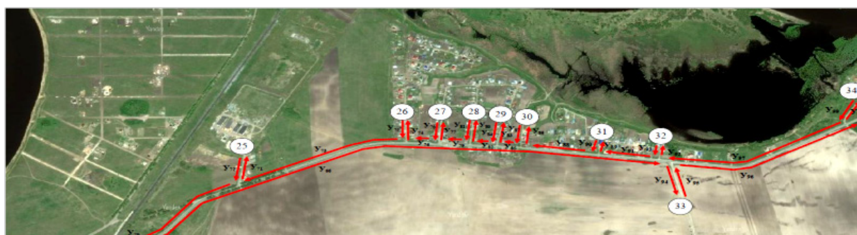
Рис. 6. Участок дороги Старый Тобольский тракт 10–13 км
