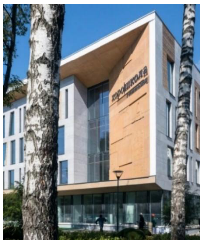
Рис. 2. Сочетание панелей из стеклофибробетона и ригельного остекления
