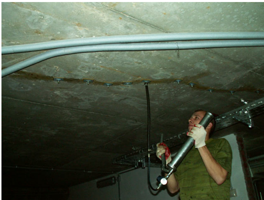
Рис. 1. Работы по инъектированию бетонных трещин
